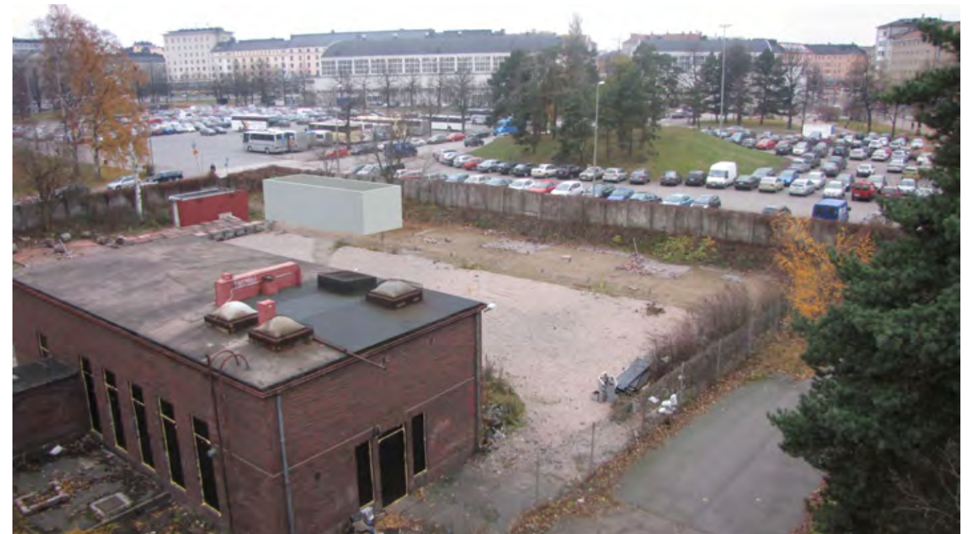
Kuva 6.79. Stadionin etukentän pystykuilu.
