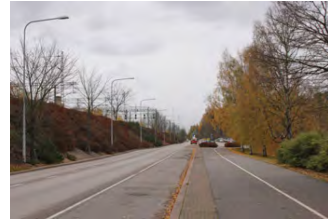
Kuva 6.52. Vauhtitietä reunustaa toiselta puolelta ratapenger. Vauhtitiellä on historiallista merkitystä Eläintarhan kilpa-ajojen lähtö- ja maalipaikkana.
