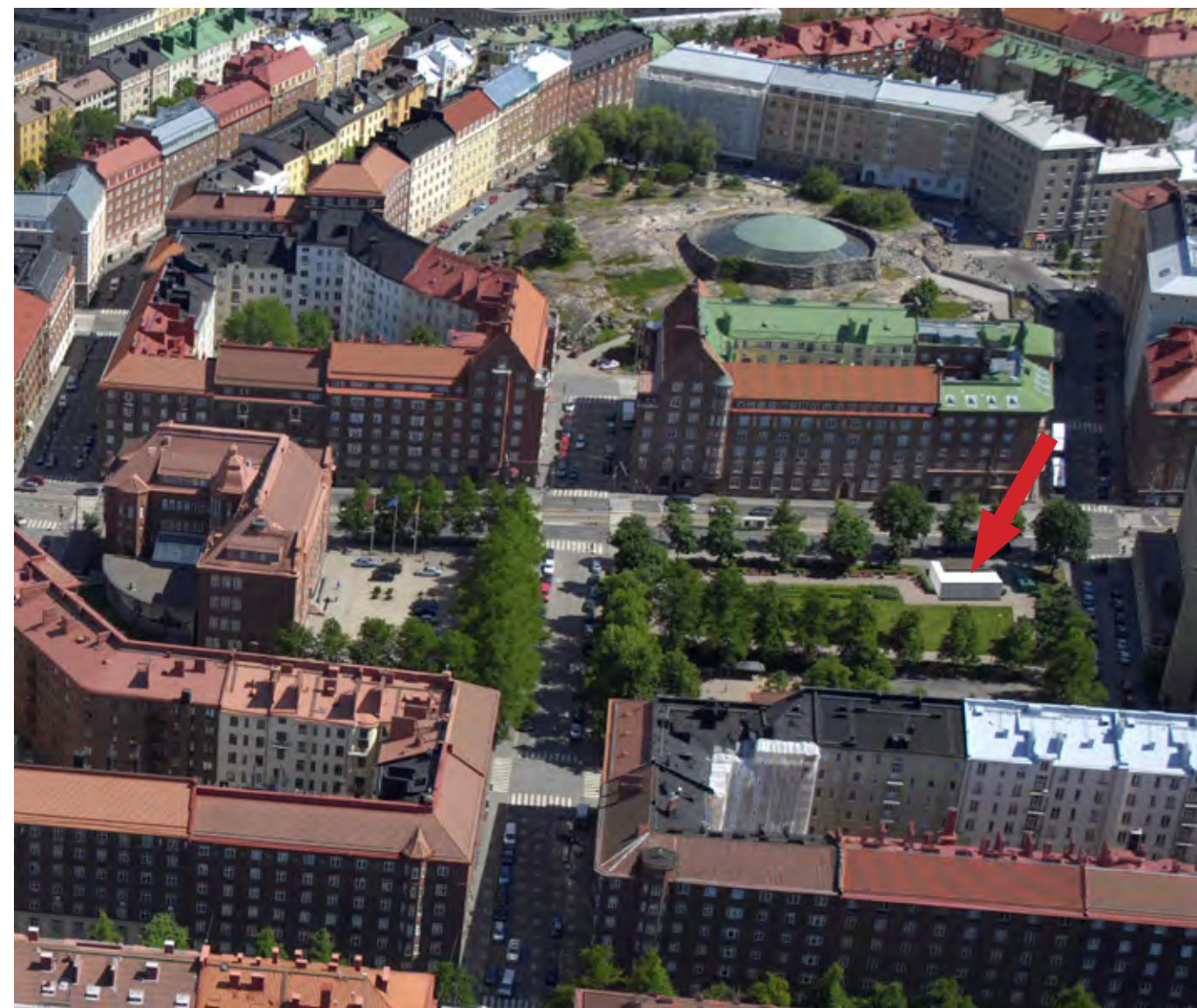
Kuva 6.80. Sammonpuistikon pystykuilu nykyisen pysäköintilaitoksen sisäänkäynnin yhteydessä. Havainnekuvan laattimisen jälkeen pystykuilun maanpäällisiä osia pienennettiin (katso Kuva 1.36.).
