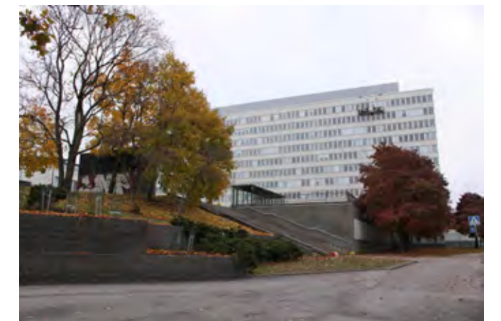
Kuva 6.101. Hakaniemen ajotunnelin virastotalon portaiden kohdalla. Alue palautetaan Pisaran valmistuttua.
