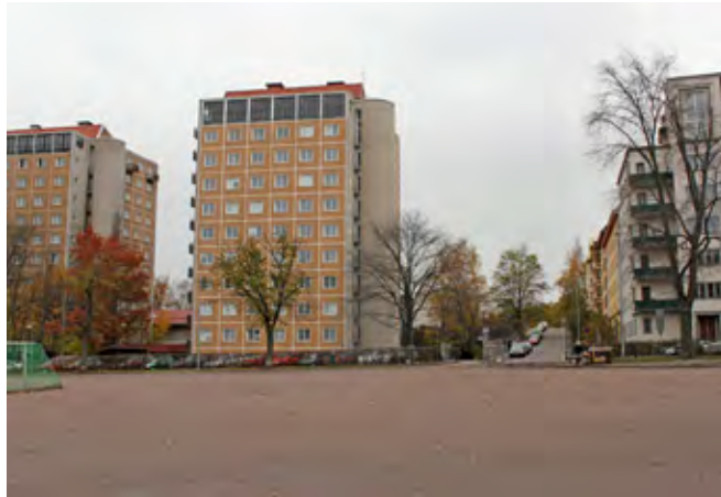
Kuva 6.102. Hesperian Esplanadin työnaikainen ajotunnelin suuaukko sijoittuu kuvassa keskellä näkyvän asuinkerrostalon ja kadun väliin.
